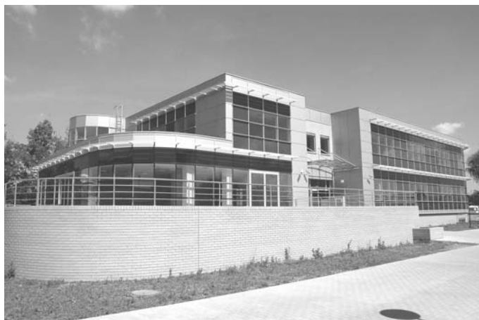
Rys. 2. Budynek dydaktyczny „Centrum Wodnego” SGGW
