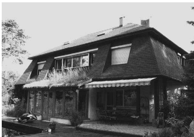
Rys. 6. Budynek z biotycznym dachem w Magdalence
