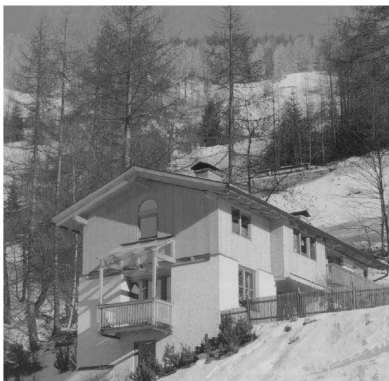
Rys. 4. Budynek w stylu regionalnym osadzony w skale stoku alpejskiego, Hermagor w Niemczech
