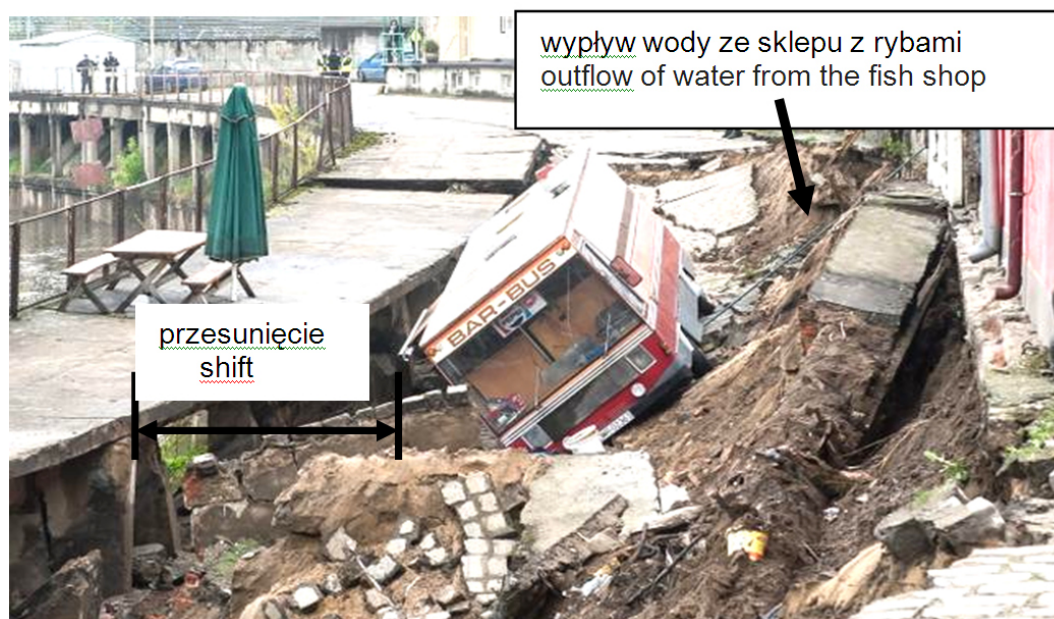
Rys. 5. Stan osuwiska w dniu katastrofy na początkowym odcinku Fig. 5. The state of the landslide on the day of the disaster at its initial section
