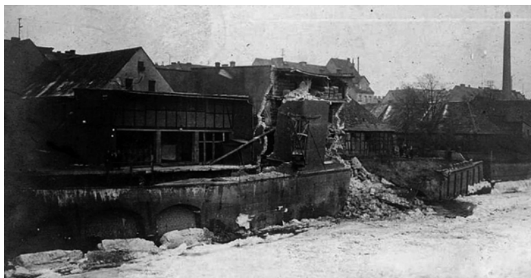
Rys. 2. Zniszczenia nabrzeża portowego Odry we Wrocławiu 29 stycznia 1907 roku
