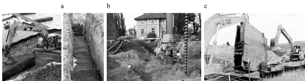
Rys. 1. Wykop bez zabezpieczeń, wykonanie bariery ciągłej z żelaza zero-wartościowego ZVI (Vertex Environmental, 2015) – a; wykop zabezpieczony ściankami szczelnymi przed wypełnieniem ZVI, Karlsruhe, Niemcy (RUBIN, 2006) – b; wykop zabezpieczony za pomocą systemu typu box – instalacja kombinowanej PBR z ZVI w Cheyenne, WY, USA (RTDF, 2001) – c
