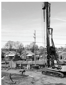
Rys. 4. Instalacja PBR za pomocą mieszania wgłębne w St. Louis, MO, USA (Geo-Solutions, 2017)
