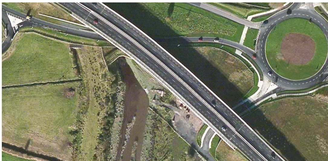
Rys. 1. Widok z góry na wykonane wiadukty (Microsoft Bing Maps)
