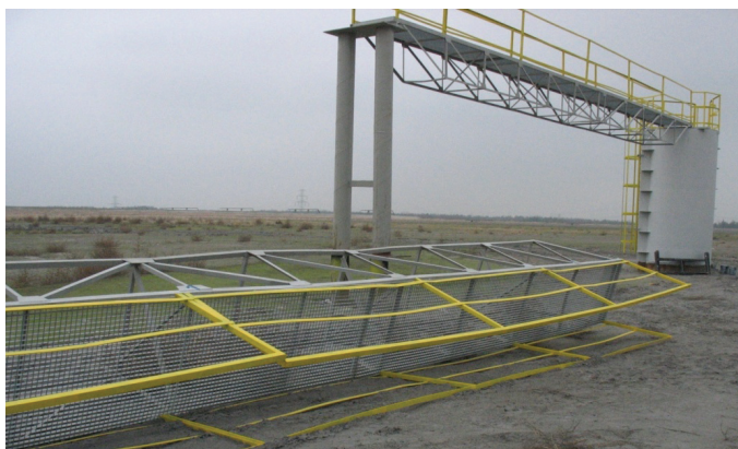
Rys. 3. Budowa pomostu na składowisku przy Elektrowni Kozienice (fot. Energoprojekt – Warszawa SA)
