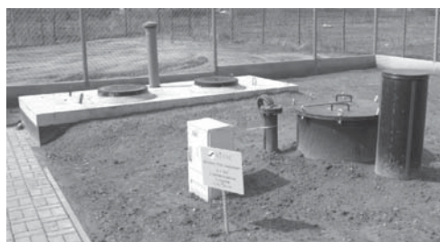
Rys. 3. Zbiornik podciśnieniowy z komorą zasuw Fig. 3. The vacuum tank with valves chamber
