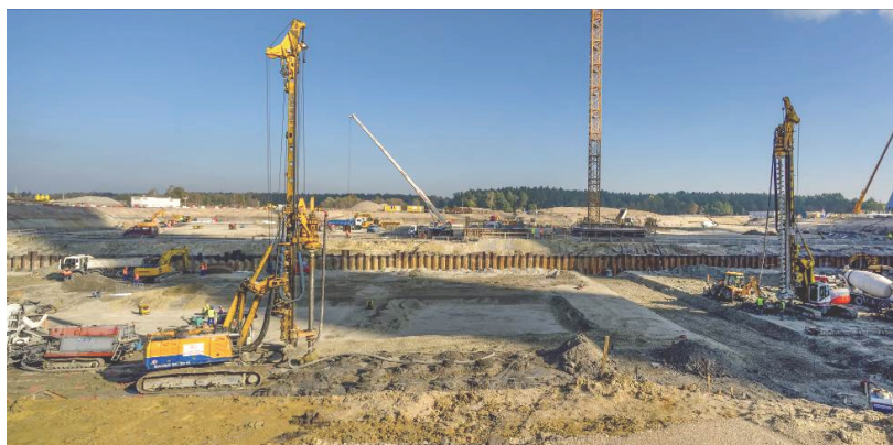
Rys. 12. Realizacja wzmocnienia podłoża fundamentów maszynowni bloków nr 5 i 6
