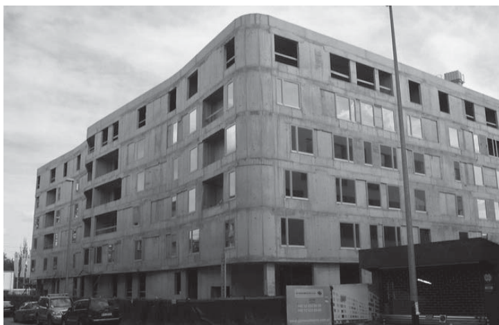
Rys. 10. Przykład realizacji budynku mieszkalnego w technologii monolitycznej żelbetowej, Krak-Chem, Apartamenty „Przy Bulwarze”, Kraków (fot. A. Radziejowska)
