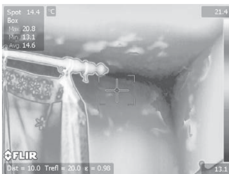
Rys.1. Rozkład temperatury na powierzchni nadproża w kuchni
