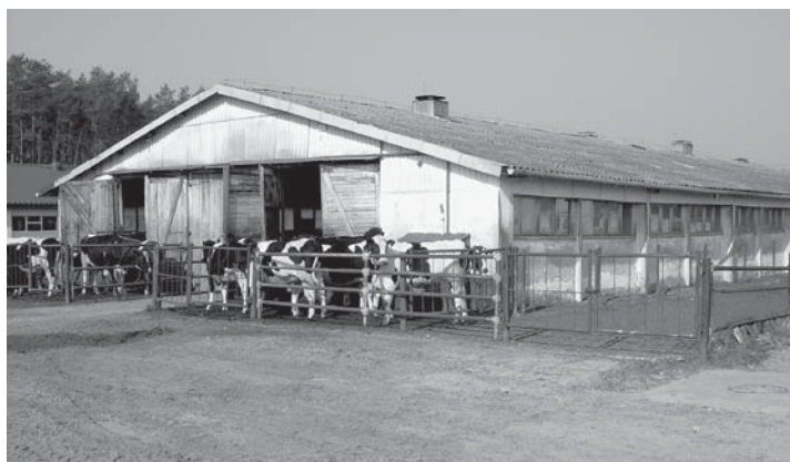
Rys. 1. Widok obory przed modernizacją Fig. 1. View of the barn before modernization
