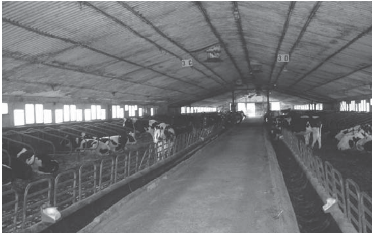
Rys. 3. Wnętrze obory przed modernizacją, widoczny korytarz paszowy i żłoby oraz brak świetlika i szczeliny wentylacyjnej w dachu Fig. 3. The interior of the barn before modernization, visible corridor and feed feed hoppers and lack of skylight and ventilation gap in the roof
