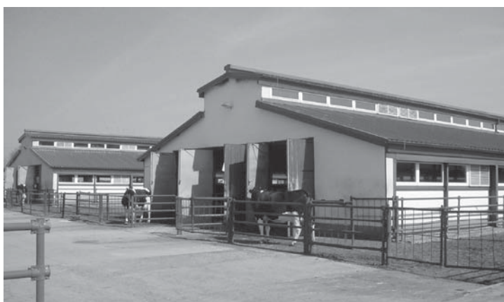
Rys. 2. Widok obory po modernizacji Fig. 2. View stalls after modernization
