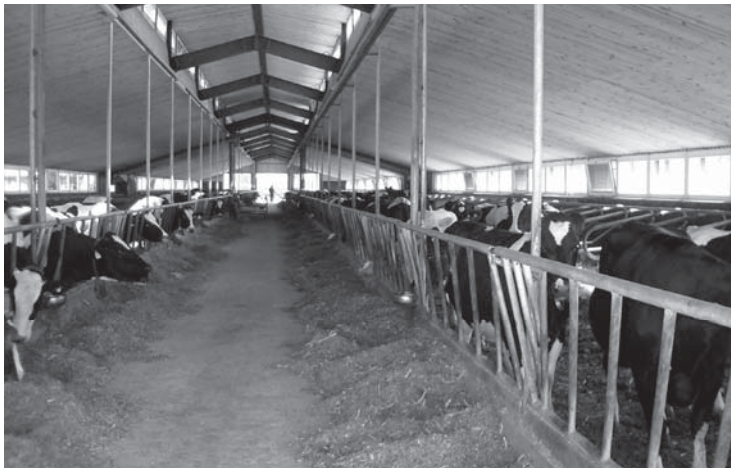
Rys. 4. Wnętrze obory po modernizacji, widoczny korytarz paszowy ze stołem paszowym i świetlik dachowy ze szczeliną wentylacyjną w dachu Fig. 4. The interior of the barn after modernization, visible feeding passage with a table feed and skylight with ventilation slot in the roof
