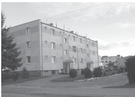
Rys. 10. Udana próba modernizacji we wsi Rusko, woj. wielkopolskie (fot. R. Barek)
