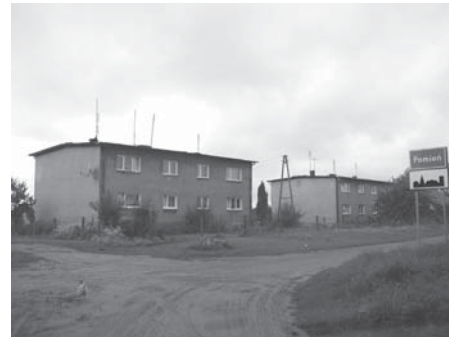
Rys. 4. Budynki z lat 60. XX wieku we wsi Pomień, woj. zachodniopomorskie
