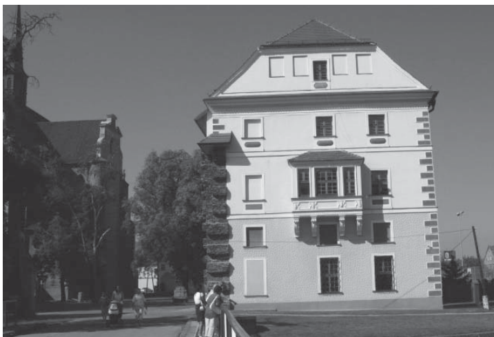
Rys. 14. Wykusz w klasztorze w Kamieńcu Ząbkowickim (fot. Z. Borcz) Fig. 14. The bay in Kamieniec Ząbkowicki convent (photo Z. Borcz)
