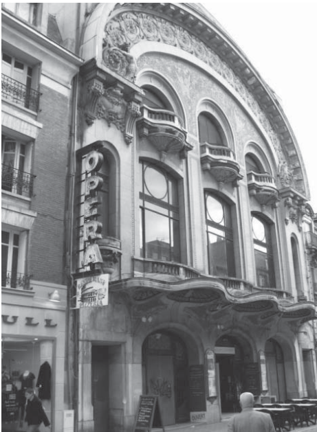
Rys. 6. Secesyjna elewacja opery w Reims, Francja (fot. Z. Borcz)
