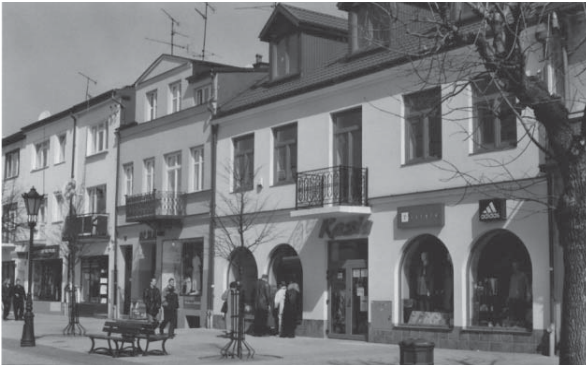
Rys. 8. Balkony przy głównej ulicy w Kutnie (fot. Z. Borcz) Fig. 8. Balconies in the main street of Kutno (photo Z. Borcz)
