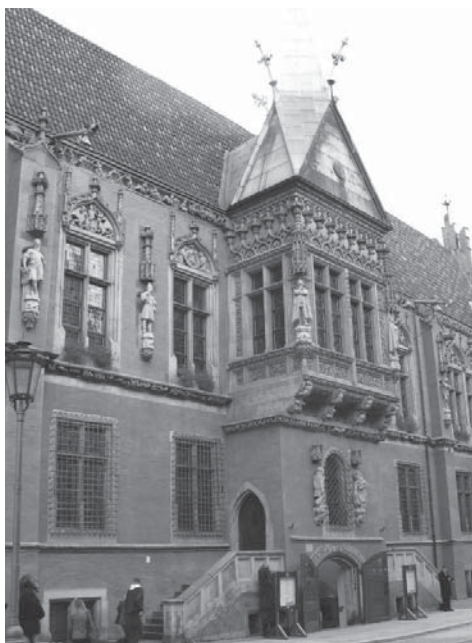
Rys. 15. Wrocławski ratusz, wykusz od strony południowej (fot. Z. Borcz) Fig. 15. The Wrocław town hall with a bay on the South side (photo Z. Borcz)
