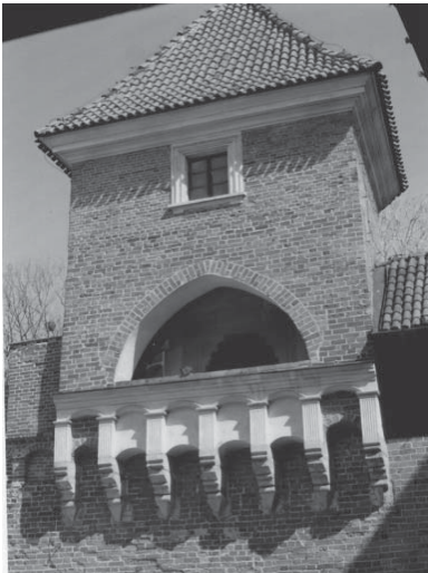
Rys. 1. Zamek w Oporowie z XVII wieku, widoczne hurdycje na wieży (fot. Z. Borcz)
