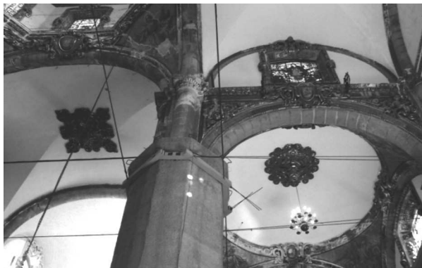
Fig. 23. Steel ties-temporary protections of pillars (photo by author) Rys. 23. Doraźne zabezpieczenie filarów za pomocą ściągow stalowych (fot. autor)
