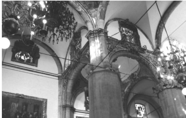
Fig. 22. Steel ties-temporary protections of pillars (photo by author) Rys. 22. Doraźne zabezpieczenie filarów za pomocą ściągow stalowych (fot. autor)
