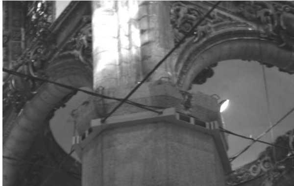
Fig. 24. Steel ties-temporary protections of pillars – detail of pillar’s head (photo by author) Rys. 24. Doraźne zabezpieczenie filarów za pomocą ściągów stalowych – szczegół (fot. autor)
