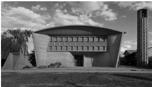
Fig. 5. Iglesia de Cristo Obrero y Nuestra Señora de Lourdes, Estación Atlántida, 1958 – church designed by Eladio Dieste
