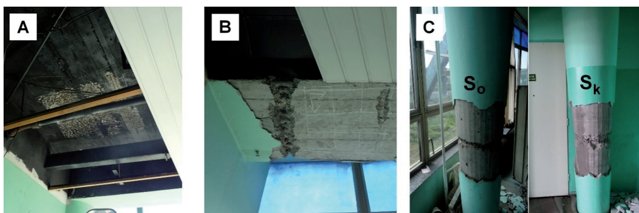
Rys. 4. Zdjęcia badanych elementów: płyty (A); belki (B), słupów S_o i S_k (C) na dworcu autobusowym PKS w Kielcach Fig. 4. Photos of tested elements: of the slab (A); beam (B) and columns S_o and S_k (C) at PKS bus station in Kielce
