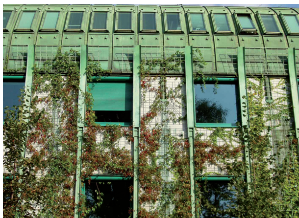
Rys. 1. Fragment elewacji budynku Biblioteki Uniwersytetu Warszawskiego jako przykład integracji zieleni i architektury w systemie bezpośrednim, tj. wykorzystania konstrukcji wsporczych dla roślin (źródło: www.mbarch.pl ; dostęp 27.10.2018)
