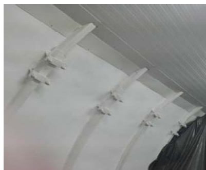
Rys. 9. Hala produkcyjna – ściana łukowa murowana z cegły i wzmocniona żebrami stalowymi (fot. W. Chojecki)
