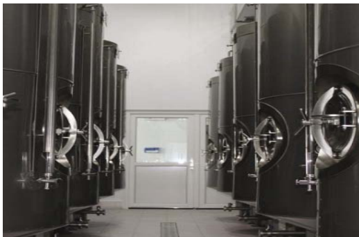
Rys. 3. Hala produkcyjna – wnętrze (fot. W. Chojecki)
