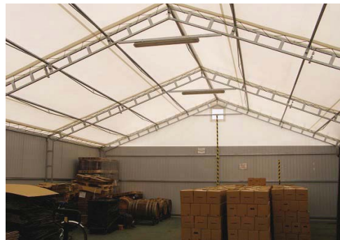
Rys. 4. Hala magazynowa – wnętrze (fot. W. Chojecki)
