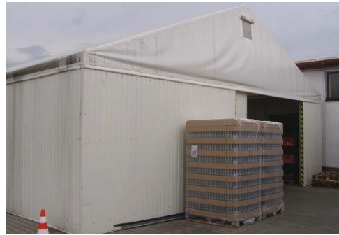
Rys. 2. Hala magazynowa (fot. W. Chojecki)
