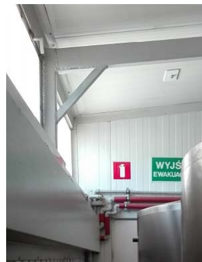
Rys. 12. Dźwigar dachowy (fot. W. Chojecki) Fig. 12. Roof girder (photo by W. Chojecki)
