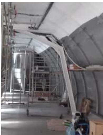
Rys. 11. Stalowy wspornik (fot. W. Chojecki) Fig. 11. Steel cantilever (photo by W. Chojecki)
