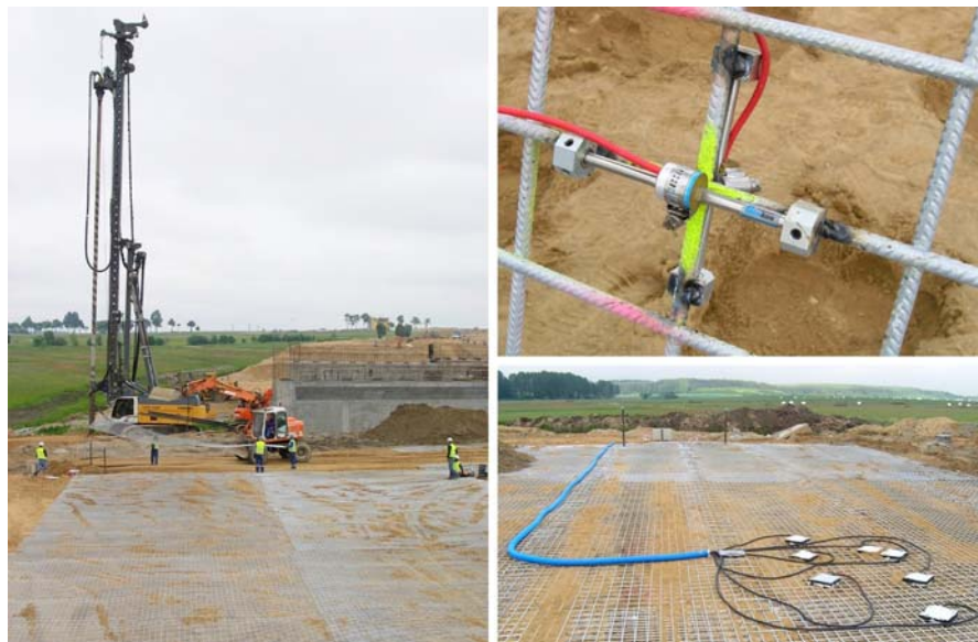
Rys. 5. Układanie siatek stalowych oraz czujniki strunowe zamontowane na siatkach (i w szczelnych obudowach) Fig. 5. Steel grid arrangement and vibrating wire sensors on grid (and in hermetic housings)
