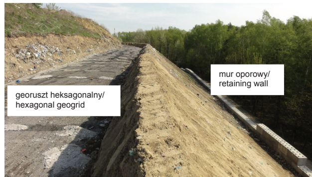
Rys. 4. Stabilizacja skarpy składowiska nad konstrukcją oporową georusztem heksagonalnym Fig. 4. Hexagonal geogrid stabilization of slope above the retaining structure
