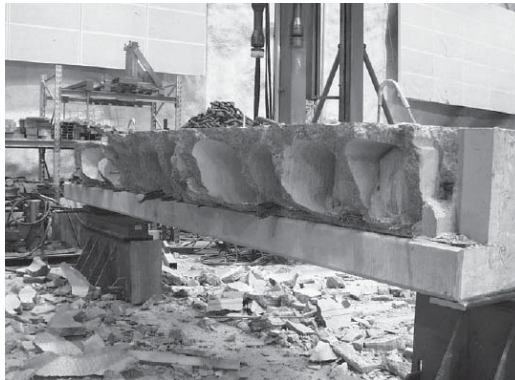
Rys. 6. Zniszczenie stropu z płyt kanałowych (wypełnienie kanałów) Fig. 6. Failure of hc floor slab (core filling) [Research Report... 2006]
