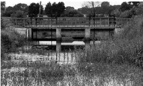
Rys. 2. Jaz w Elżbietowie w 5,6 km Łasicy, widok od strony wody górnej (fot. A. Włodarczyk) Fig. 2. Elżbietów – weir on the Łasica Channel (photo A. Włodarczyk)
