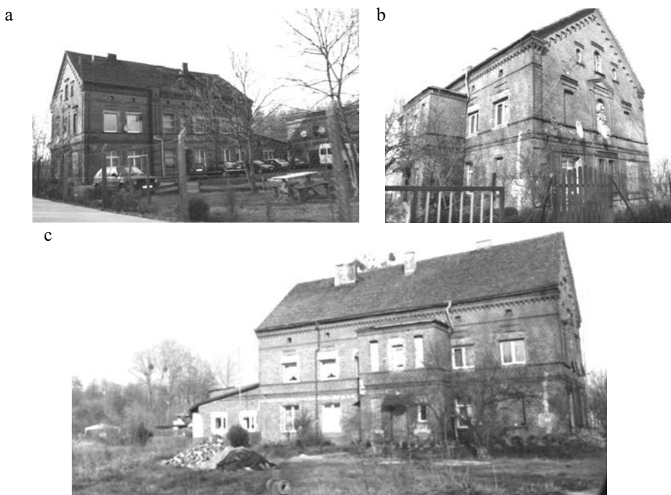
Rys. 7. Były dom opieki we wsi Brzostowo: a – elewacja frontowa, b – elewacja boczna, c – elewacja tylna, stan obecny (fot. I. Niedźwiecka-Filipiak)
