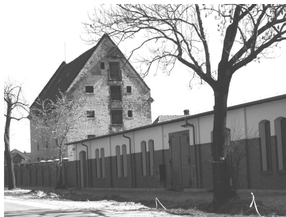
Rys. 4. Wieża mieszkalna w zespole folwarczny z XIV–XV wieku w trakcie rewaloryzacji i zmiany funkcji na cele turystyczne (fot. autorki)
