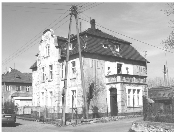
Rys. 2. Nietypowa zabytkowa willa w Jordanowie Śląskim z ciekawym architektonicznie zwieńczeniem, dachem uskokowym i innymi detalami architektonicznymi (fot. autorki)
