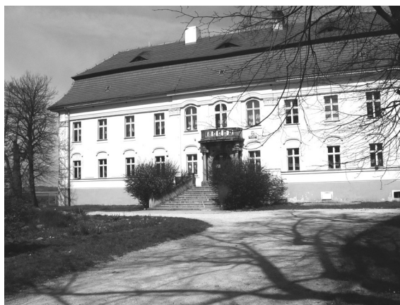
Rys. 9. Odrestaurowany pałac z XVIII wieku z dachem uskokowym, z powiekami we wsi Świątniki, obecnie szkoła podstawowa (fot. autorki)
