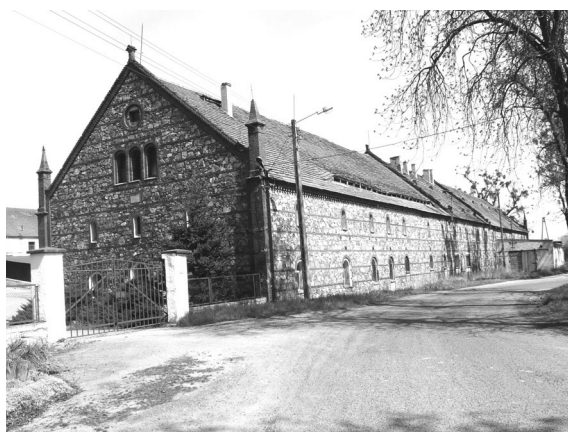
Rys. 8. Kamienno-ceglana stajnia w byłym zespole folwarcznym we wsi Karolin, obecnie magazyny (fot. autorki)
