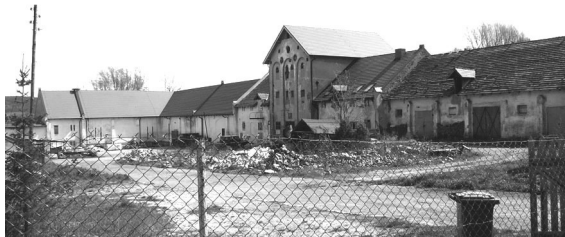
Rys. 10. Dawny zespół dworsko-folwarczny w Będkowicach w trakcie rewitalizacji i rewaloryzacji z przeznaczeniem na działalność hotelarsko-gastronomiczną (fot. autorki)
