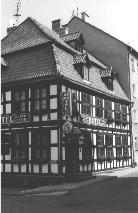
Rys. 5. Budynek w Kamieniu Pomorskim przy ul. Gryfitów, o konstrukcji ryglowej z dachem mansardowym
