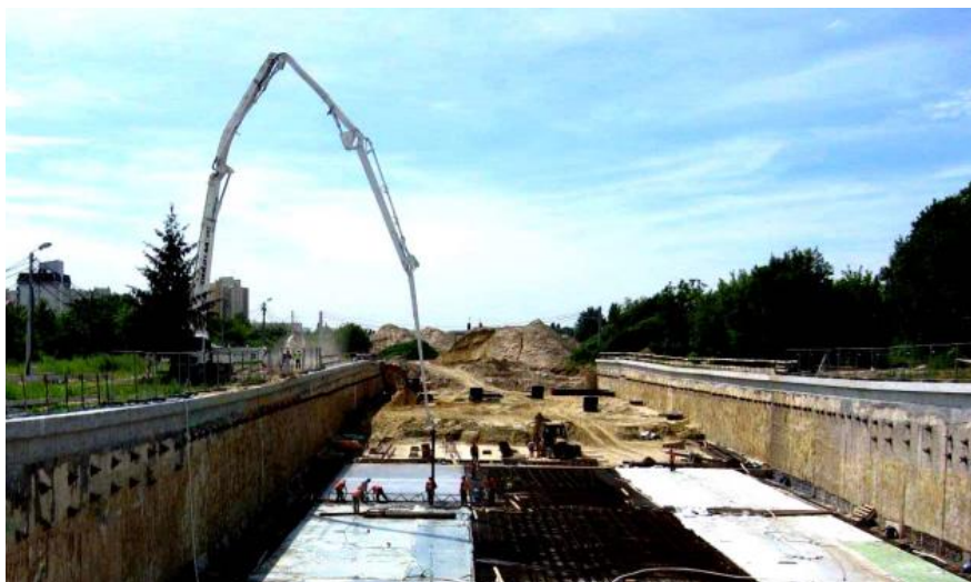
Rys. 1. Trasa S8 – odcinek Radiowo: a – schemat obliczeniowy; b – prace przy wykonaniu płyty dennej (Stolec, 2010) Fig. 1. Route S8 – Radiowo section: a – calculation scheme; b – work on making the bottom plate (Stolec, 2010)
