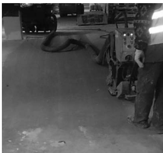
Rys. 1. Przygotowanie podłoża poprzez śrutowanie (fot. A. Majstrowicz)
