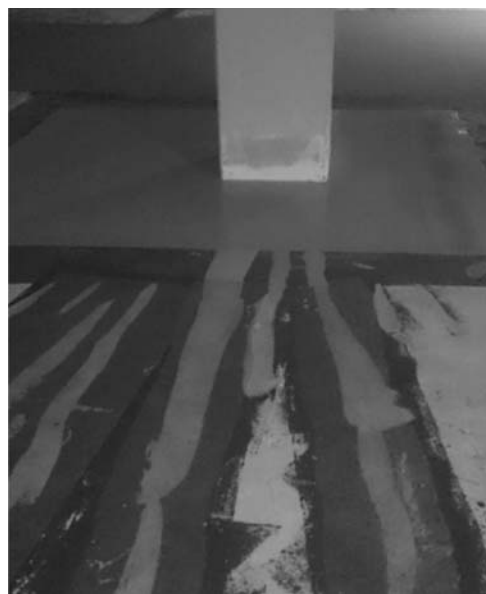
Rys. 11. Widok rys kondygnacji –1 po wykonaniu naprawy powierzchniowej (fot. A. Majstrowicz)
