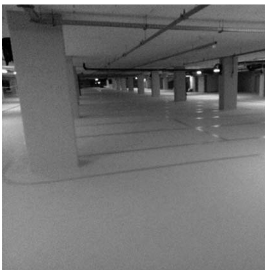
Rys. 13. Prawidłowo wykonana posadzka żywiczna kondygnacji –1 (fot. A. Majstrowicz)
