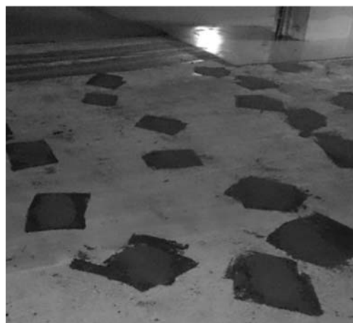
Rys. 4. Lokalne naprawy podłoża (fot. A. Majstrowicz)
