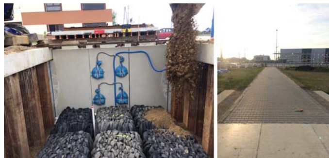
Rys. 4. Czujniki sił parcia zainstalowane na ścianie pomiarowej podczas wykonywania zasyпки (z lewej), odcinek dojazdowy (z prawej) Fig. 4. Pressure sensors installed on the measuring wall during performing backfill (left), all approach section (right)
