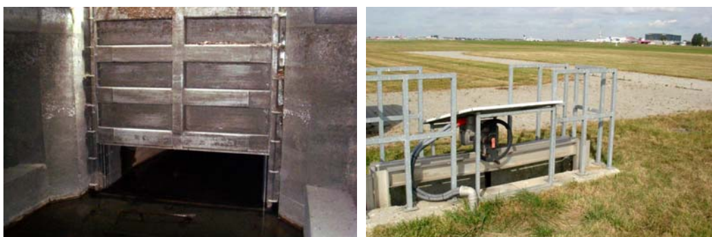
Rys. 3. Zastawka zlokalizowana w kanale głównym przy zbiornikach ZR2-3: A – widok z poziomu zbiorników; B – widok z poziomu terenu Fig. 3. Control gate located in the main channel at the reservoirs of ZR2-3: A – view from the interior of reservoirs; B – view from the ground
