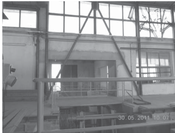
Rys. 14. Konstrukcja wsporcza z zastrzałów rurowych w miejscu likwidacji istniejącego słupa hali, aby możliwe było wykonanie zapadni kolejowej
