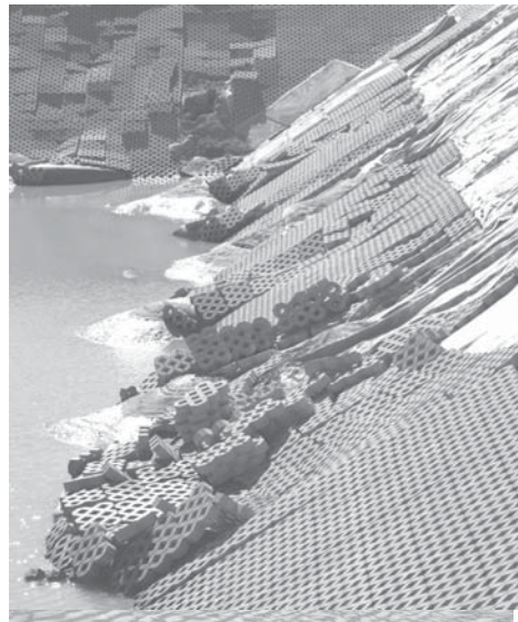
Rys. 6. Przykład zniszczeń (awarii) ścian zbiornika: a – wschodniej, b – południowej Fig. 6. Example of slope failure: a – eastern, b – southern
