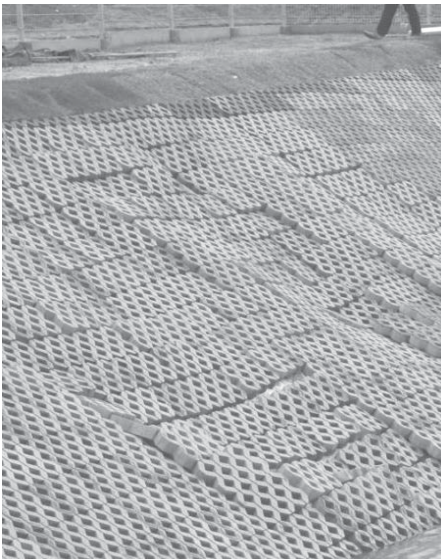
Rys. 6. Przykład zniszczeń (awarii) ścian zbiornika: a – wschodniej, b – południowej Fig. 6. Example of slope failure: a – eastern, b – southern
