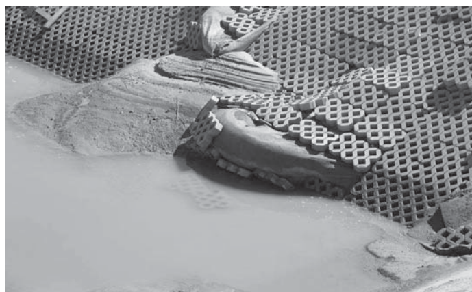
Rys. 7. Widok zniszczeń zbiornika – spływ gruntu wraz z płytami, naruszenie geowłókniny, stożki napływowe na dnie zbiornika (stan po odpompowaniu wody, 24.07.2012)
