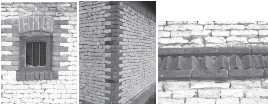
Rys. 4. Typowe przykłady zastosowania cegły ceramicznej w konstrukcjach murowanych z kamienia (fot. M. Gorączko)
