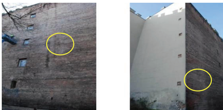
Rys. 6. Naprawione rysy wzdłuż kominów ściany szczytowej budynku Fig. 6. Fixed cracks along chimneys in front wall of the building
