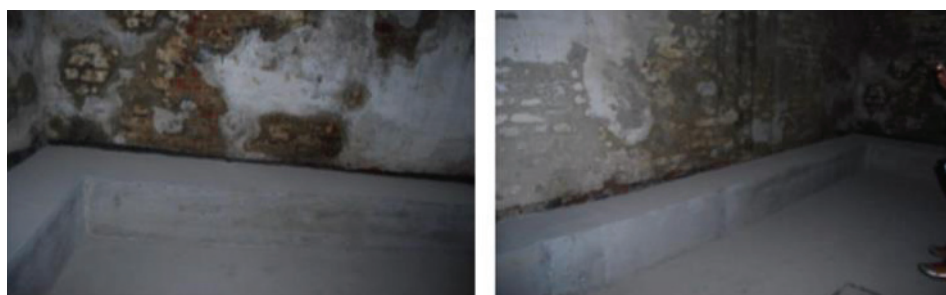
Rys. 4. Ruszt żelbetowy oraz wyrównane i naprawione ściany fundamentowe
