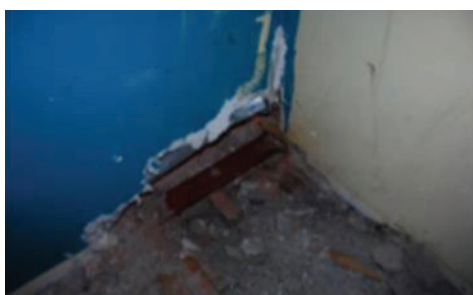
Rys. 9. Wzmocnienie stalowych belek stropowych Fig. 9. The reinforcement of steel ceiling beams
