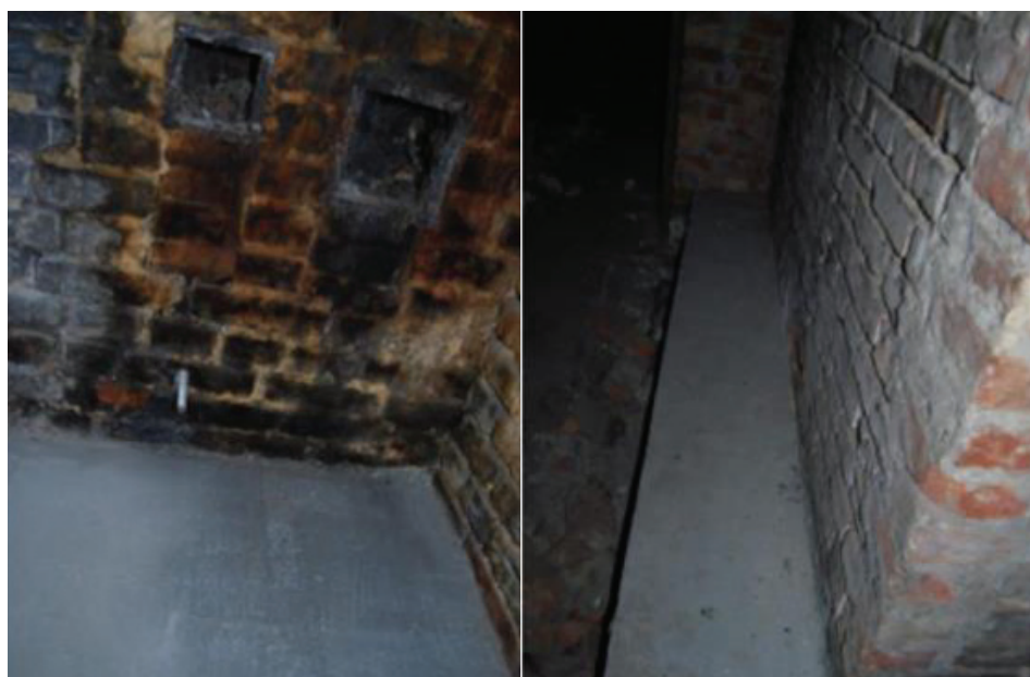
Rys. 3. Żelbetowy ruszt oraz posadzka z izolacją przeciwwodną
