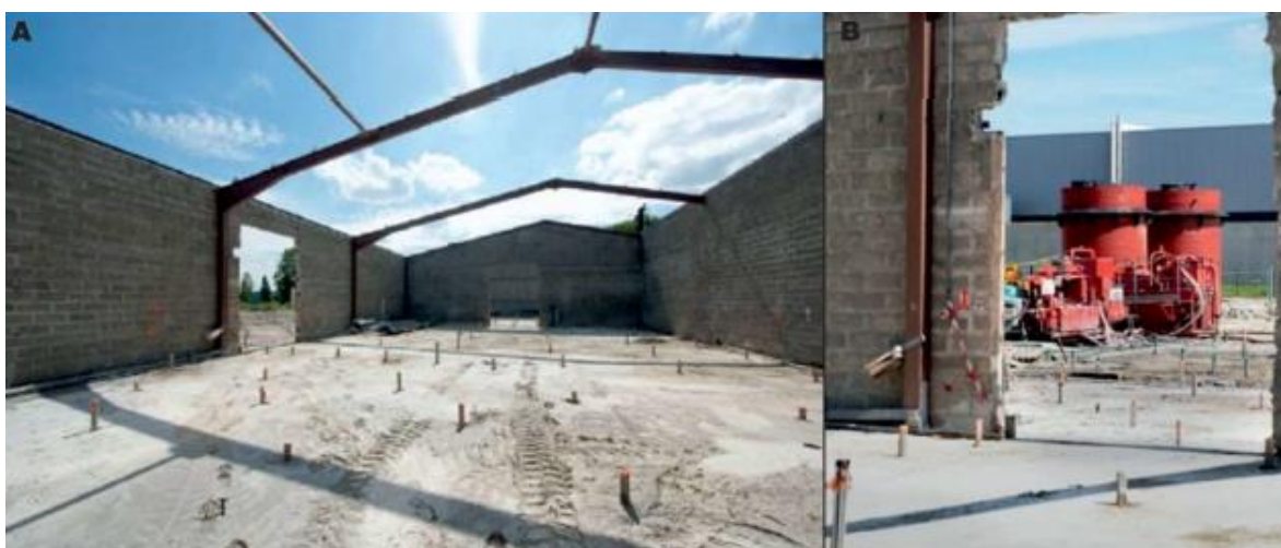
Rys. 3. Stabilizacja gruntu na analizowanym obiekcie: A – siatka punktów iniekcyjnych; B – jednostka produkująca reagent (fot. Menard)
