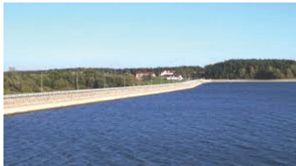
Rys. 10. Widok zapory czołowej zbiornika Nielisz (od strony WG) Fig. 10. View of main dam at Nielisz reservoir (view from upstream)
