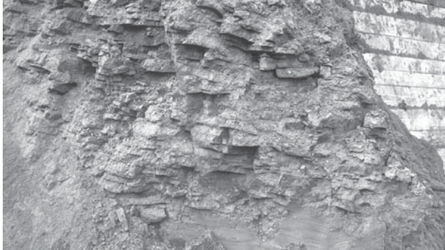
Rys. 10. Rozwarstwienia powstające w ile warwowym w wyniku odprężenia i wietrzenia Fig. 10. Delayering in the varved clay as a result of unloading and weathering
