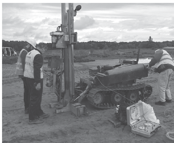
Rys. 2. Badania dylatometryczne na platformie roboczej
