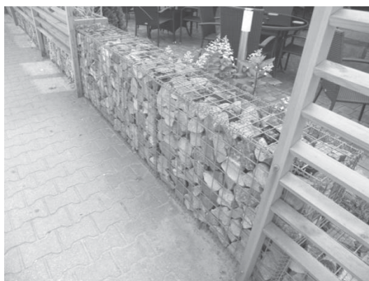
Rys. 9. Zastosowanie gabionów w aranżacji ogródka kawiarnianego, Biała Podlaska, 2013 r. (fot. M. Dudkiewicz)
