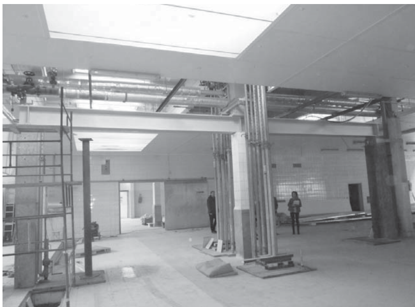
Rys. 10. Dźwigar HEB 450 osadzony na podporach
