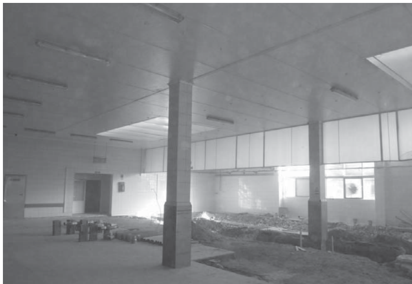
Rys. 9. Fragment hali wraz ze słupem przeznaczonym do likwidacji
