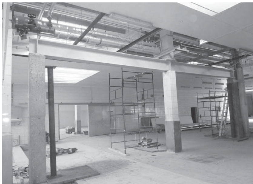
Rys. 11. Widok wykonanej konstrukcji po zdemontowaniu podpór. Pomiędzy dźwigarem HEB 450 a pozostawionym dolnym odcinkiem słupa była wolna przestrzeń wysokości około 1 cm
