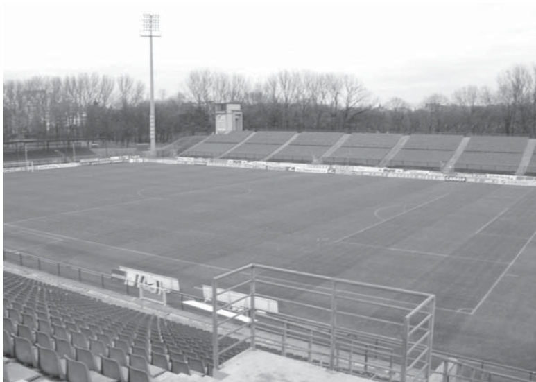
Rys. 8. Płyta boiska piłkarskiego na stadionie TS Wisła Kraków po przebudowie w 2004 roku Fig. 8. Football field Wisła Kraków after renovation in 2004
