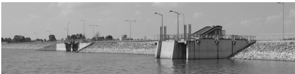
Rys. 4. Widok zapory czołowej zbiornika Nielisz od strony wody górnej [www.inzynierbudownictwa.pl]
